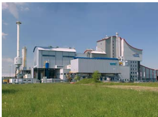
Die Thermische Restabfallbehandlungs- und Energieerzeugungsanlage in Eschbach, Landkreis Breisgau-Hochschwarzwald.
