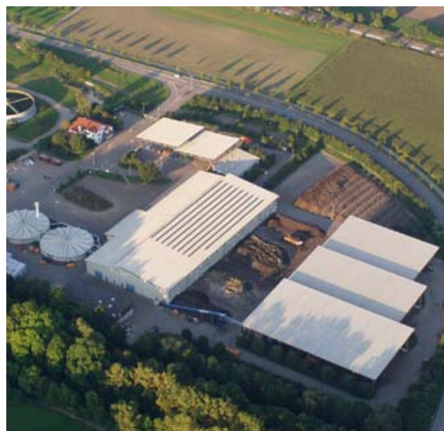
Entsorgungszentrum mit Biokompostanlage des Landkreises Heidenheim in Heidenheim-Mergelstetten.
