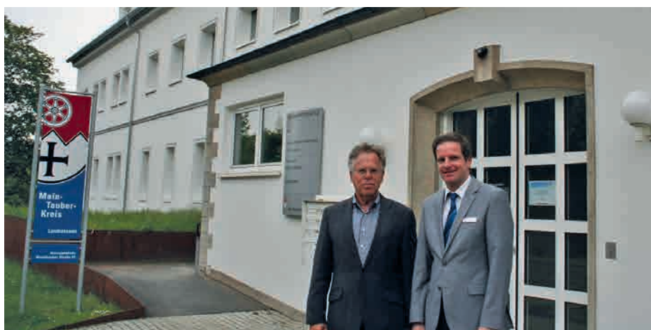
Landrat Reinhard Frank (links) und der neue Leiter des Eigenbetriebs Energie- und Immobilienmanagement, Benjamin Schneider, überzeugten sich vom gelungenen Abschluss der Sanierungsarbeiten am kreiseigenen Verwaltungsgebäude Wachbacher Straße 52 in Bad Mergentheim.
