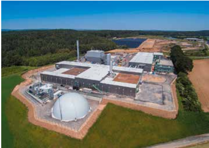
Die neue AVR Bioabfallvergärungsanlage
