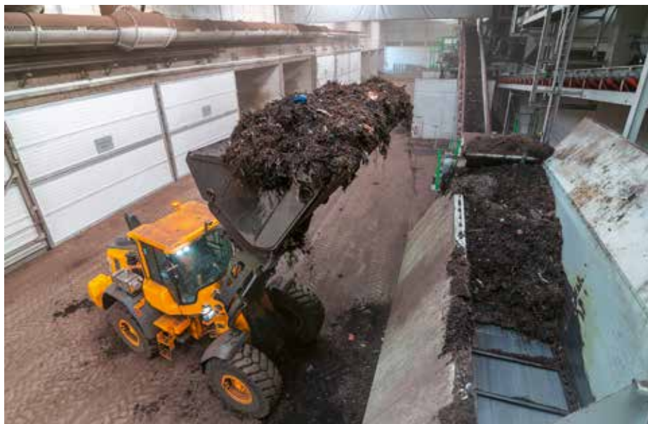
Rottehalle mit Rottetunneln (im Bild links)
