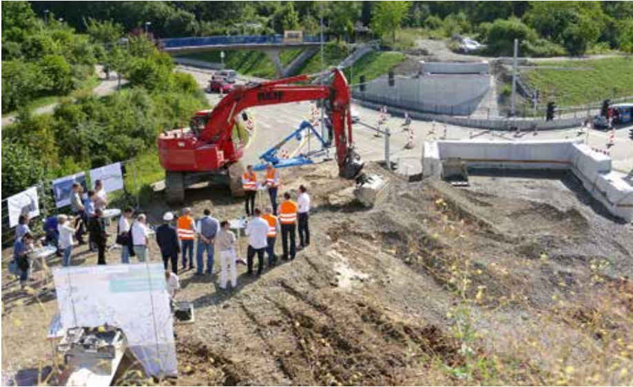
Rechts im Bild sind die neuangebrachten Widerlager für die Brücke über die B 295 zu sehen.
