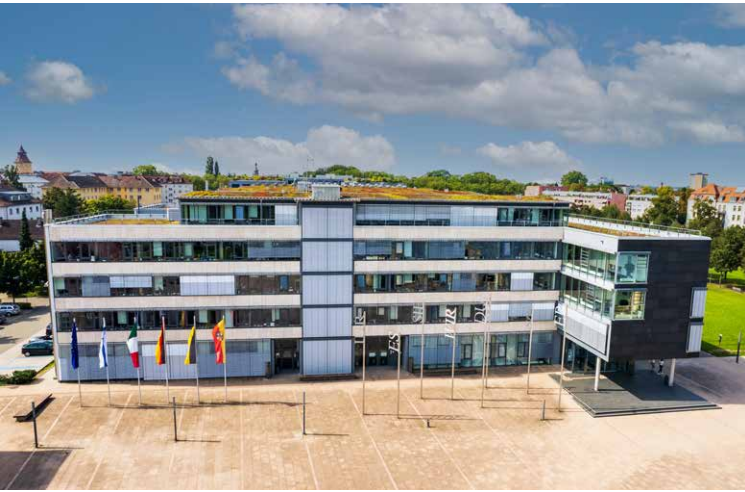
Gebäude des Landratsamtes Rastatt © Benjamin Wedewart, Landratsamt Rastatt
