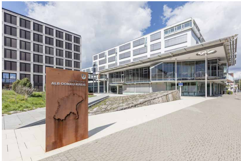
Vorplatz und Gebäude des Landratsamtes Alb-Donau-Kreis © Oleg Kuchar
