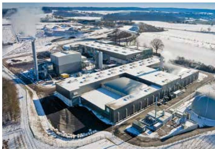
**Anlagen in Sinsheim: AVR Biomasseheizkraftwerk, AVR Bioabfallvergärungsanlage, AVR Biomethanaufbereitungsanlage**
