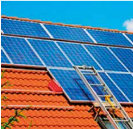
Photovoltaik-Anlagen liefern „saubere“ erneuerbare Energie. Sie sind mittlerweile relativ günstig zu installieren und können die eigenen Stromkosten senken. Ihrem Ausbau soll nun im Rahmen der Solaroffensive Nordschwarzwald neuer Schwung verliehen werden
