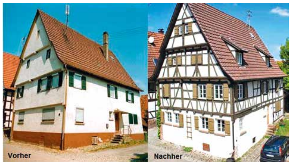
Die Renovierung von denkmalgeschützten Gebäuden trägt sichtbar zum Erhalt und zur Ästhetik des Ortsbildes und der historischen Gebäude bei.
