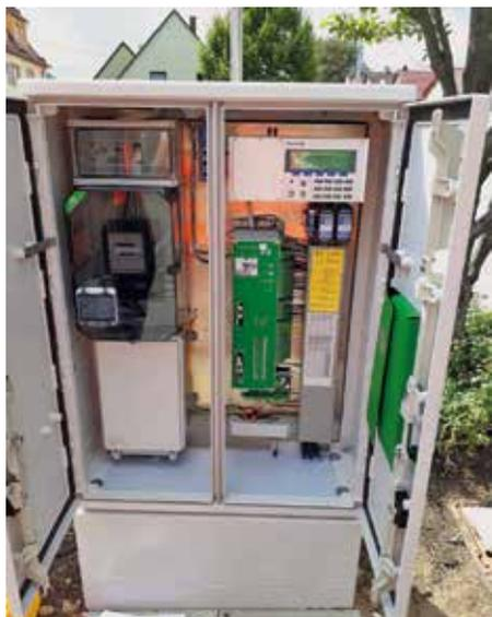
und Signalgeber. Mit den neuen intelligenten LEDs entfallen eigene Stromkabel zu jeder Lampe.
