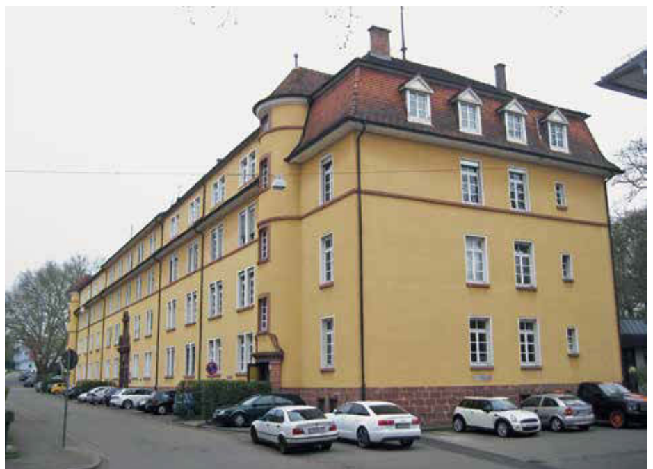
Das Land bezuschusst die Sanierung der Haustechnik in der Badischen Malerfachschule Lahr mit rund 2,3 Millionen Euro.
