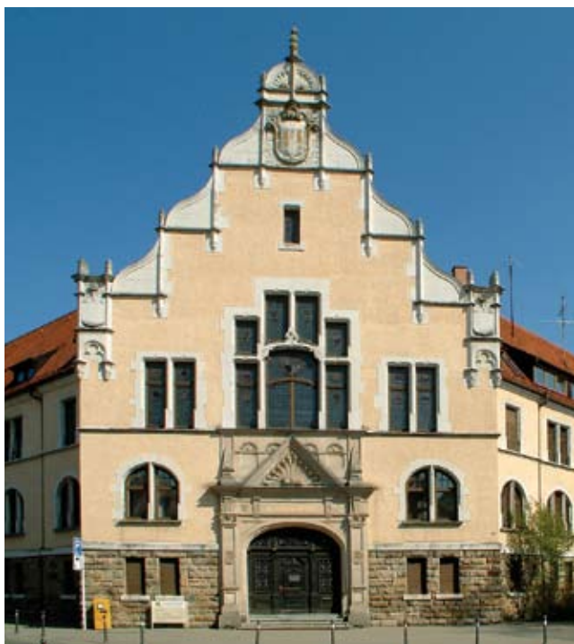
In diesem Gebäude, das 1904/05 für die Regierung des Schwarzwaldkreises erbaut wurde, ist seit 1939 das Landratsamt Reutlingen untergebracht.
