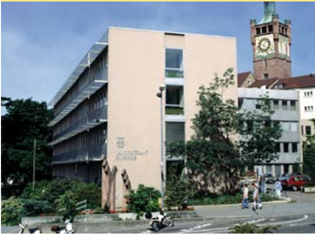
Gebäude Blumenhof 4, Sitz des Pforzheimer Landratsamtes 1956 – 1993.
