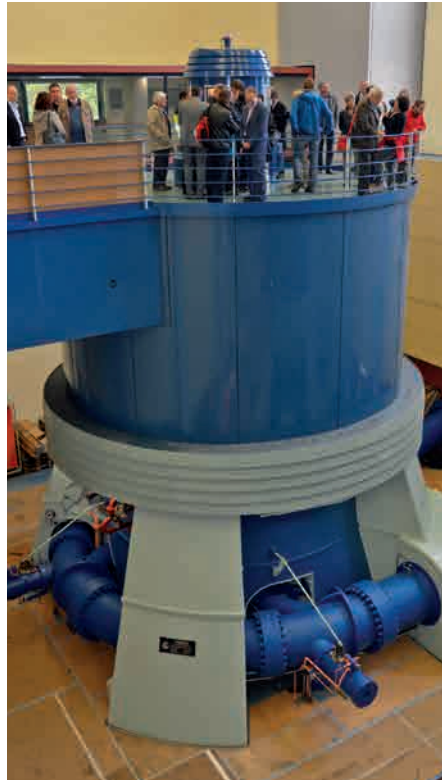
Kreisräte und Verwaltungsvertreter besichtigen das Pumpspeicherkraftwerk der landeseigenen Vorarlberger Illwerke AG in Tschagguns-Latschau.
