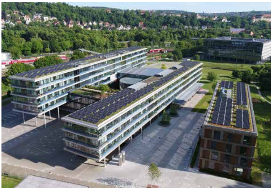
„Das Landratsamt Tübingen mit Fotovoltaikanlage. Modulfläche 1.260 m 2 , Leistung 150 kWp. Die Leistung würde ausreichen 30 Einfamilienhäuser mit Strom im Jahr zu versorgen.“
