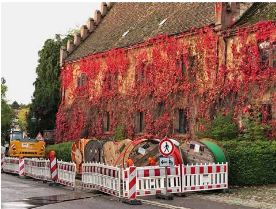
Verlegung der Breitbandinfrastruktur in Dotternhausen
