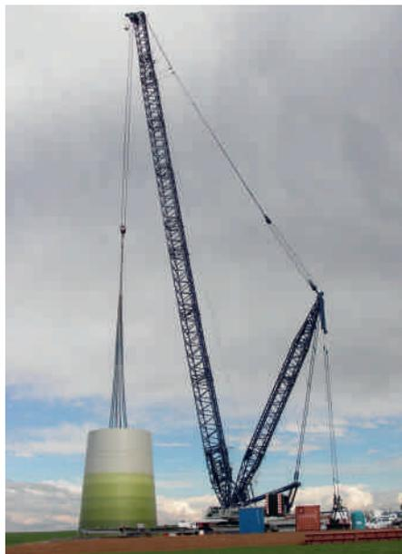
Bau einer Windkraftanlage auf Gemarkung Werbach im Main-Tauber-Kreis: Die ersten Teile des Turmes werden errichtet.
